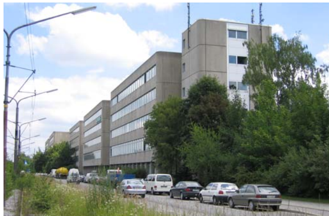
Siemens München: Licht- und Jalousiesteuerung in 11 Bürogebäuden mittels EnOcean-Funktaster
